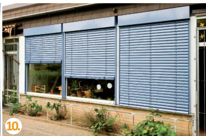
Une fois que les différentes opérations ont été réalisées, procéder à un essai. Les positions de fin de course sont déjà paramétrées. Pour être complet, l'essai doit inclure les manœuvres suivantes : fermeture et réouverture totales du tablier. Le montage du brise-soleil orientable est désormais achevé.
