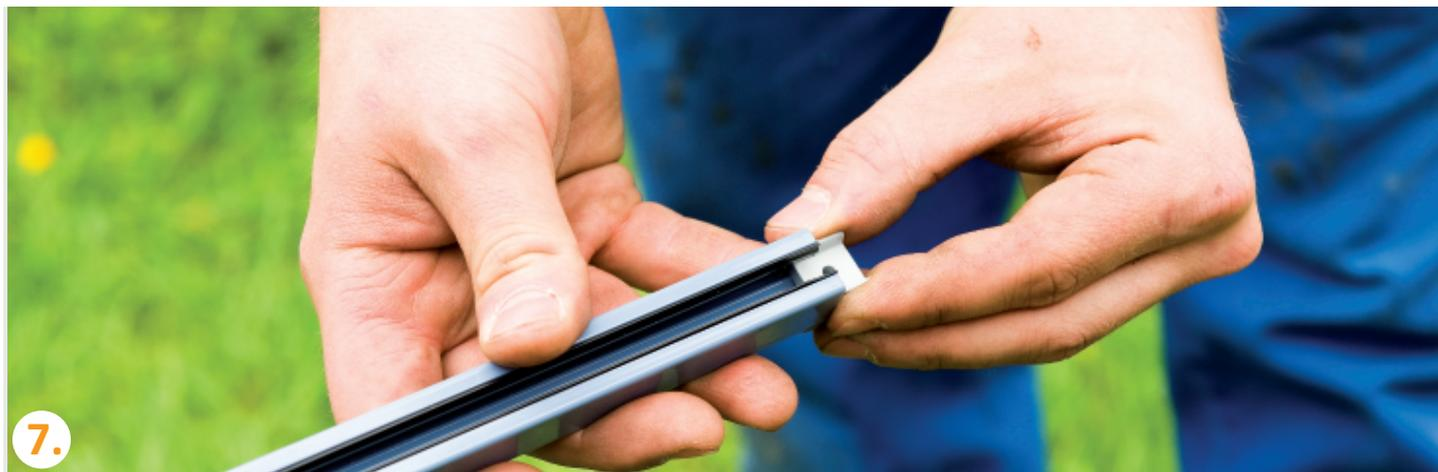
Insérer ensuite les embouts en partie basse des coulisses de guidage et les fixer.
