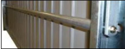
Profil tubulaire pour assurer la stabilité de la porte pour les manoeuvres d'ouvertures et de fermetures.
