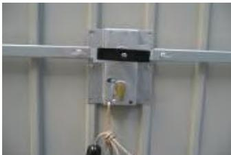
Double verrouillage indépendant au sol avec sécurité renforcée, totalement inaccessible de l'extérieur.
