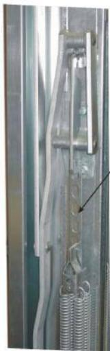
Crochets de régulation de tension des ressorts
